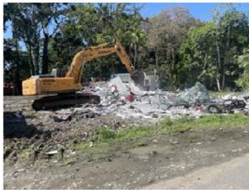
Imagen correspondiente a una de las estructuras demolidas.
